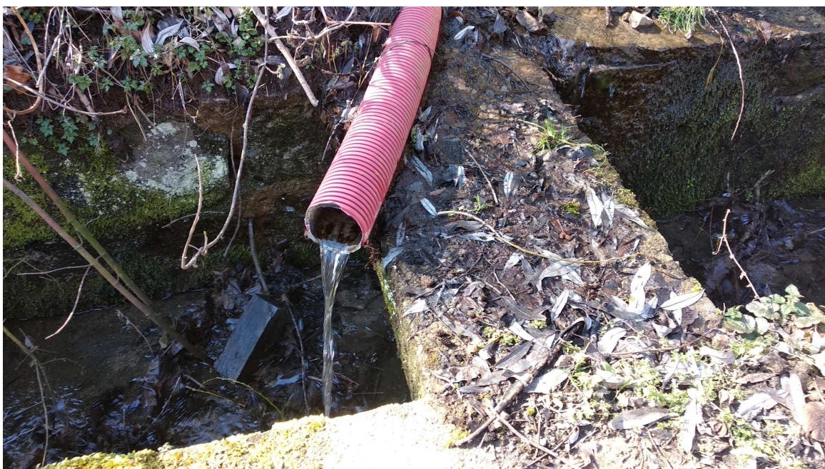
Obr. 2: Na svahu mezi fotovoltaickou elektrárnou a osou koleje dochází k intenzivním vývěrům vody. V některých případech je tato voda svedena drenážními trubkami do betonového příkopu u koleje.
