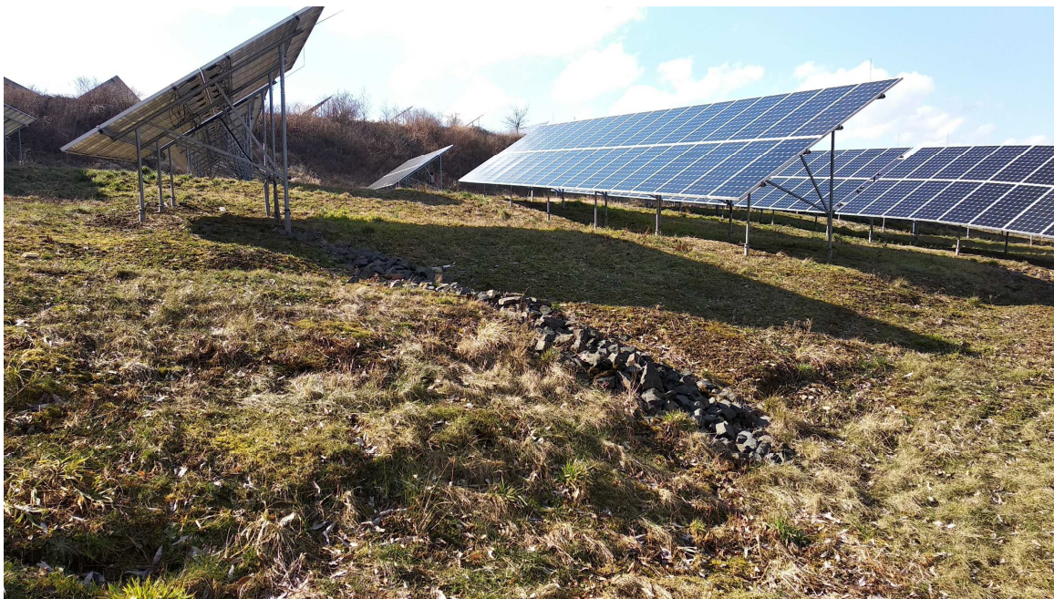
Obr. 1: Pohled na odlučné trhliny sesuvu v dolní části a na štěrkové žebro ve střední části obrázku. V těsné blízkosti sesuvu se nachází fotovoltaická elektrárna.
